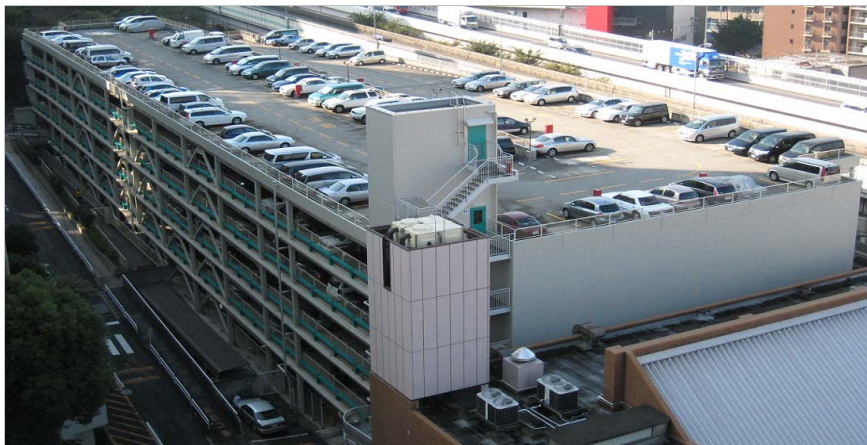
10年以上協議を行い増設された立体駐車場。分譲時からの駐車場不足解消のみならず、現在は全体修繕積立金をまかなえる施設に。
